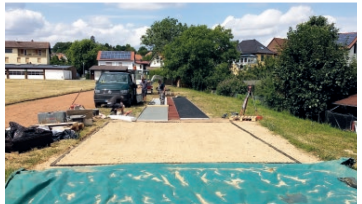
Renovierungsarbeiten an der Weitsprunganlage
