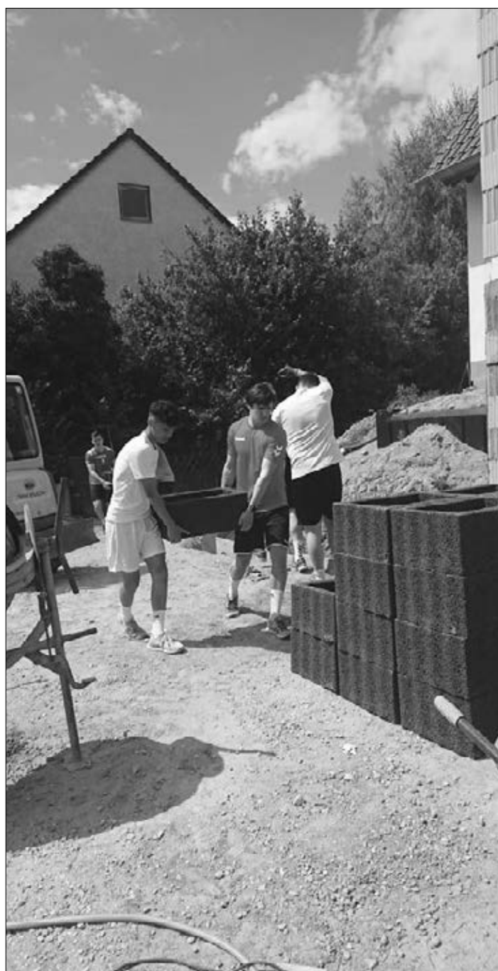
Arbeitseinsatz auf der Baustelle
